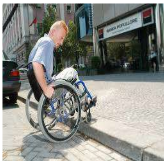
Falta de nivel de acceso
